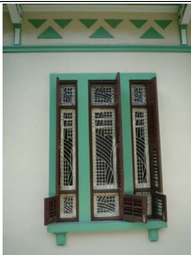
Figura 5.5.5: Pormenor de uma janela
